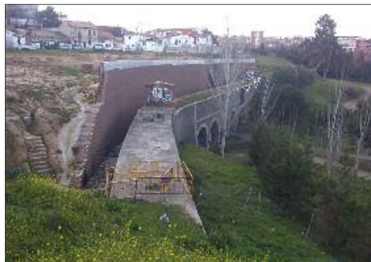
Un tramo del acueducto encajonado por las obras.
