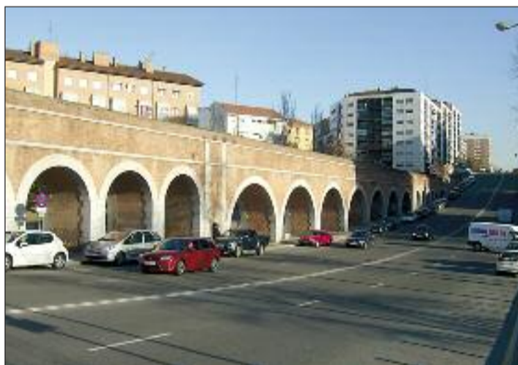
Acueducto de Amaniel (2013).
