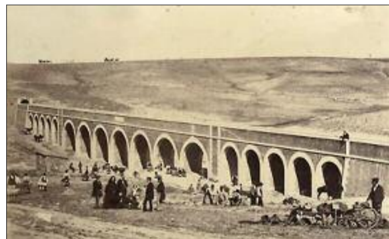
Acueducto de Amaniel (1856).
